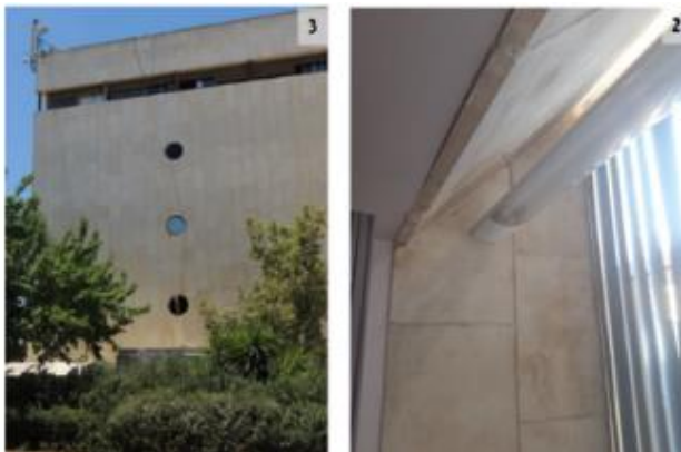
איור 13 תוספותיו של רכטר. מימין- חלון שובר אור של רכטר, משמאל- חלונות עגולים וחלון סרט בקומה העליונה, מתוך תיק התיעוד
