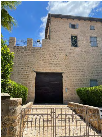
מבט לדלת הכניסה לאחר השימור
