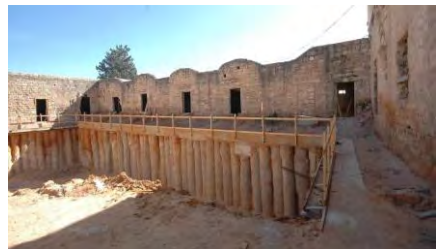
תהליך יציקת היסודות הקונסטרוקטיביים בחצר הפנימית של מבנה החאן, במקביל להוספת קומה תת קרקעית לחללי שירות.
